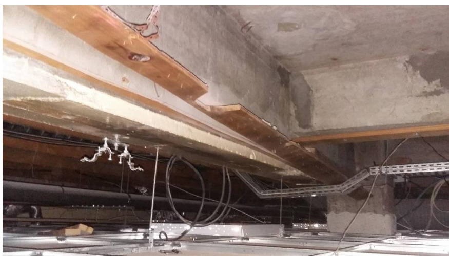
poteaux avec chapiteaux d'appuis des poutres
