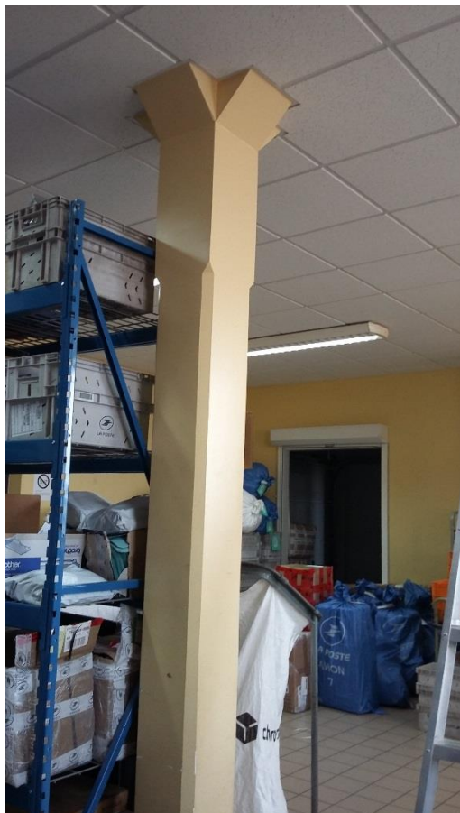
poteaux avec chapiteaux d'appuis des poutres
