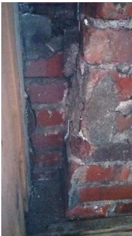
murs double épaisseur de 8 cm : 1 er étage côté mer / 2 e étage côté place
