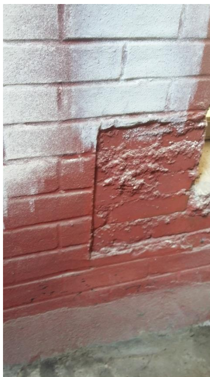
ancien enduit taloché (fausse briques) sur mur en briquettes 1 er étage côté mer (local sur voûte en béton)
