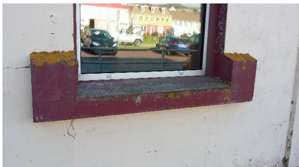
éclats de béton localisés
