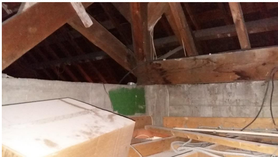
poutraison supérieure de l'édicule, support de la charpente centrale
