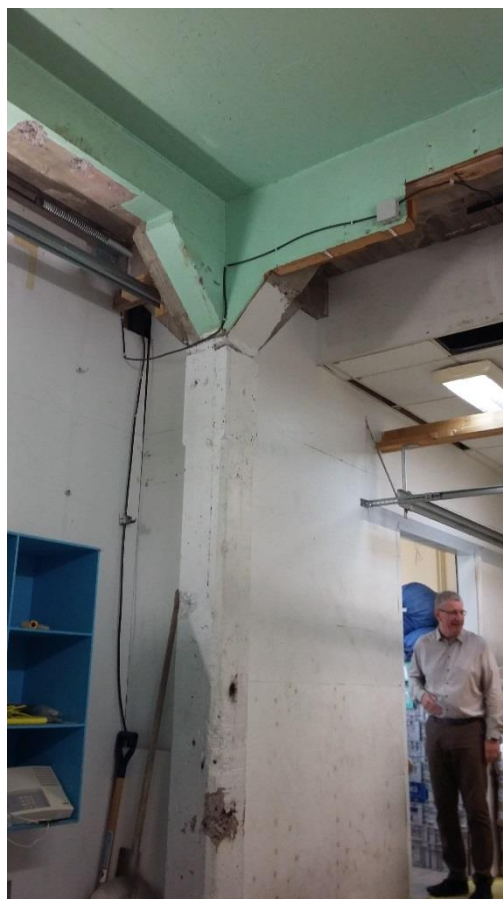
poteaux avec chapiteaux d'appuis des poutres
