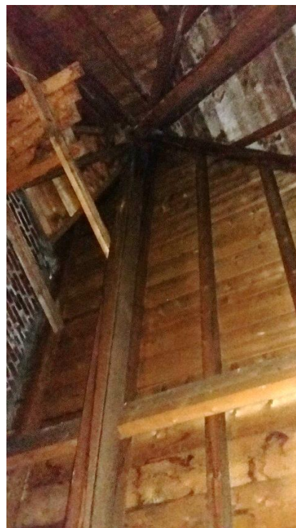
charpentes centrales des combles et de l'édicule
