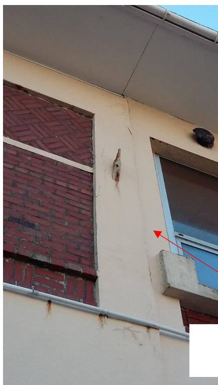
joints de structures entre bâtiments, recréés par dilatations thermiques
