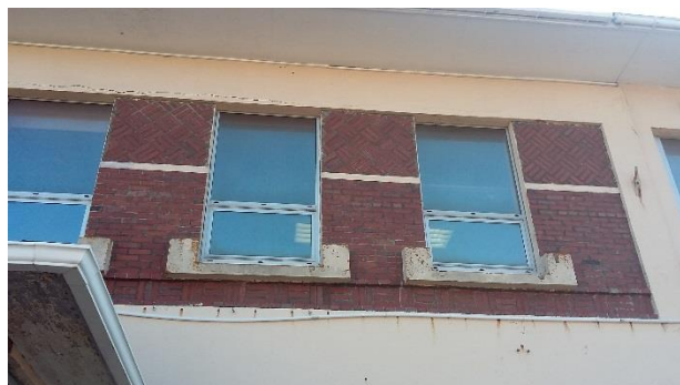
éclats de béton localisés
