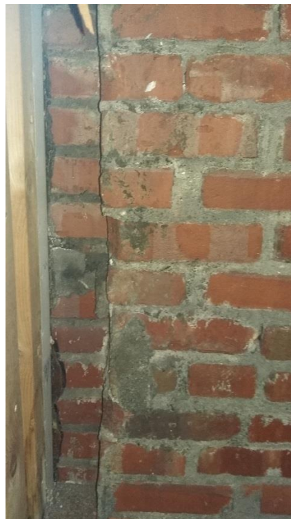
murs double épaisseur de 8 cm : 1 er étage côté mer / 2 e étage côté place
